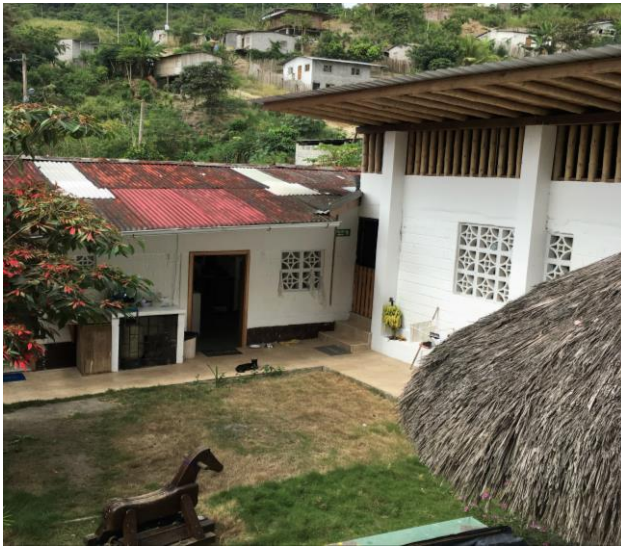
Vorher, Innenhof mit altem Dach
